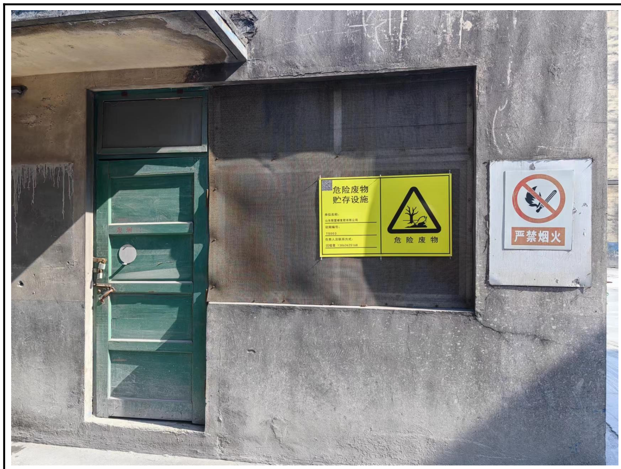
图 4.1-3 危险废物暂存间
