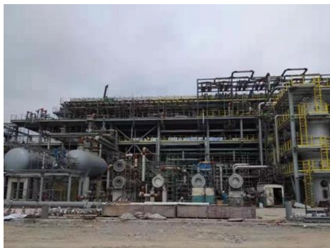
石化安装工程
