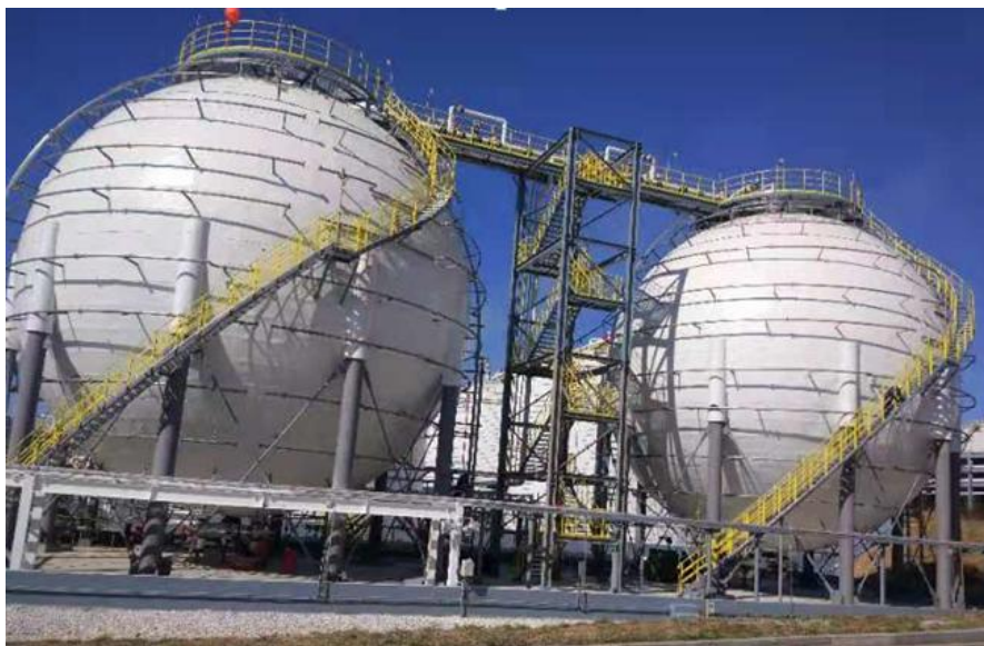
公司承接的球罐安装工程
