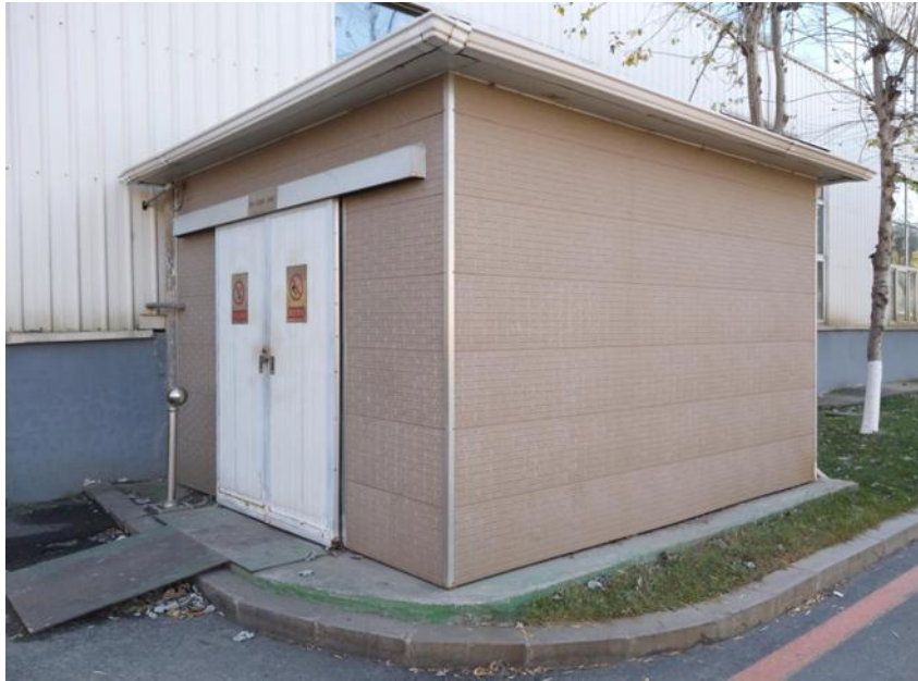
公司对化学品仓库进行了改造，确保化学品存放安全
