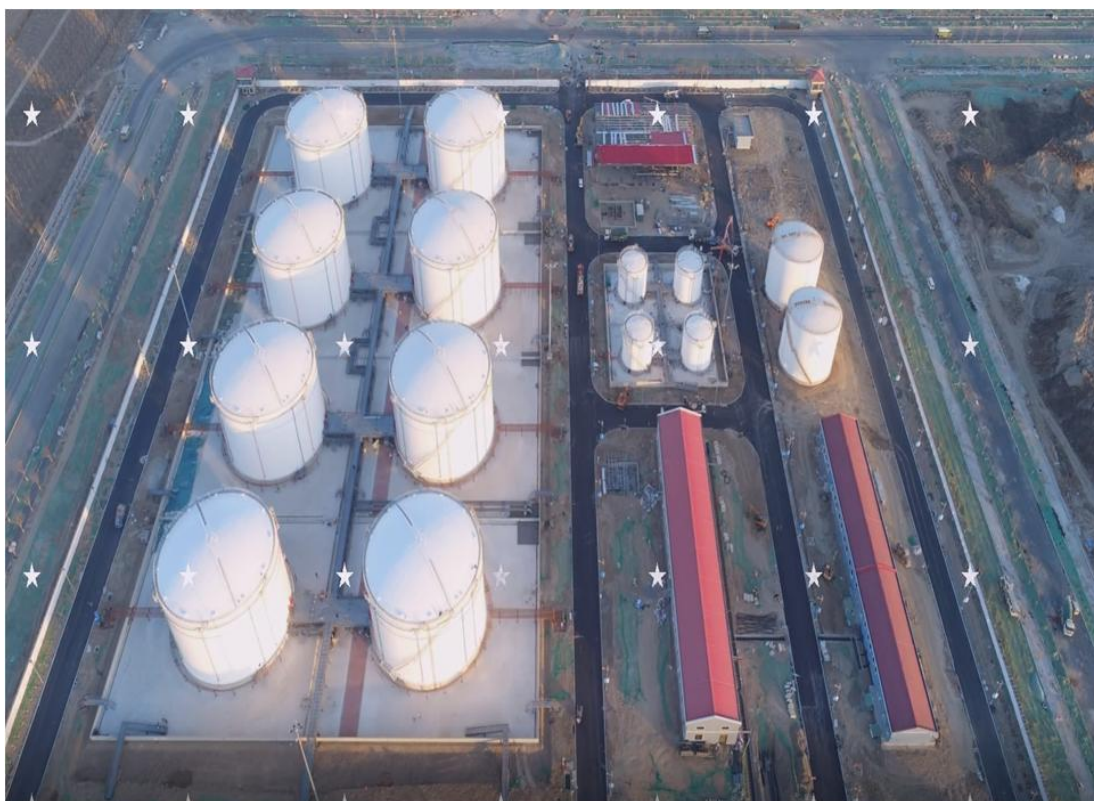
公司施工过程中重视环境保护工作
