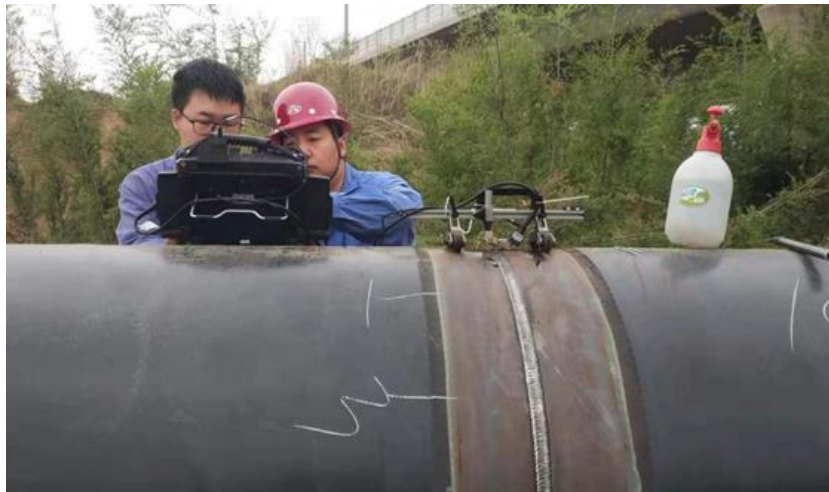
公司通过相控阵超声检测方法，成功解决了 “沈阳燃气集团燃气管网过青年大街”射线检测难题
