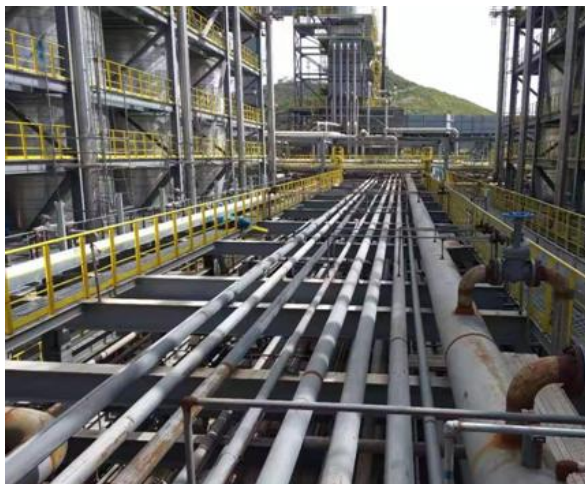
石化安装工程
