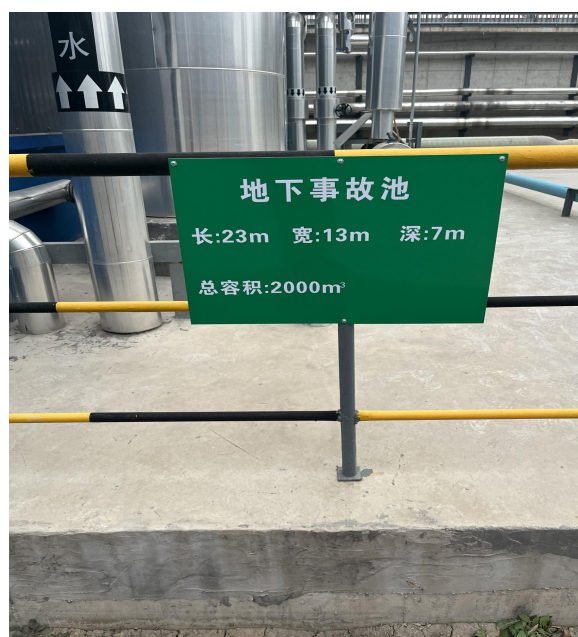
图 7.1 地下事故池照片
