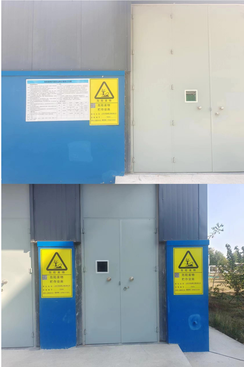
图 2.3 (1) 危废库外部照片
